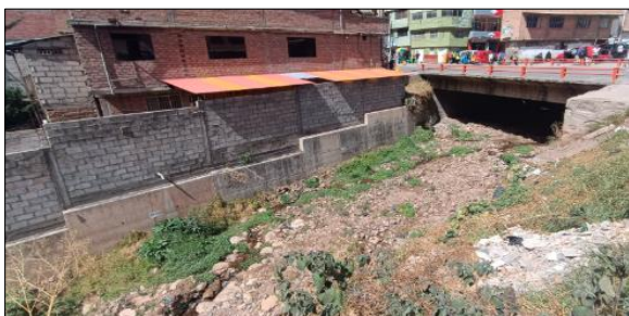
FIGURA N°03: Cauce de la quebrada pasando por debajo de un puente vehicular, parte de la Carretera Central, con una evidente acumulación de residuos y maleza, lo que reduce la capacidad de desfogue del agua.
