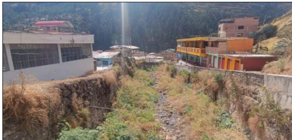
FIGURA N°02: Vista de la quebrada con una gran estructura de concreto parcialmente oculta por la vegetación, lo que podría generar una obstrucción y alterar el flujo.
